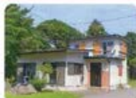
グループホーム1号館
